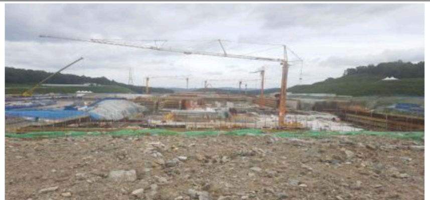
고에너지B구역 (B1F 벽체 철근배근 및 Conc 타설)
