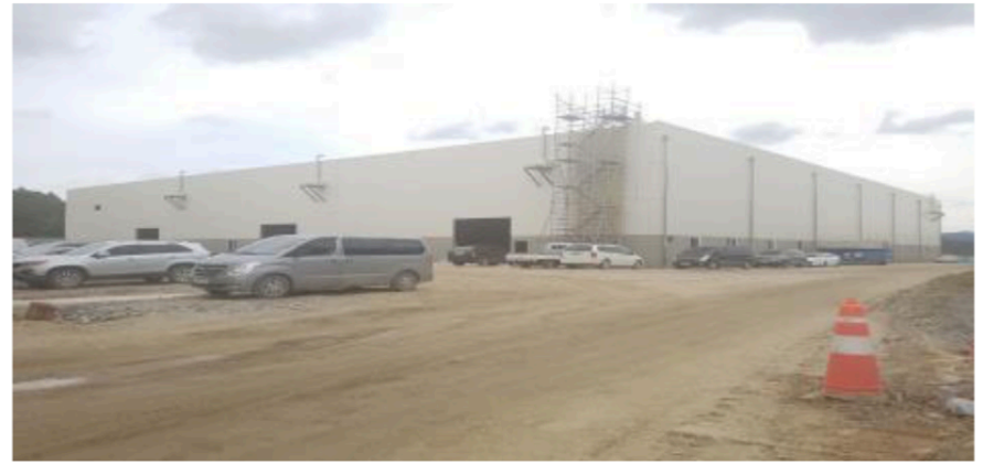
초전도조립동 (내부 마감 공사)
