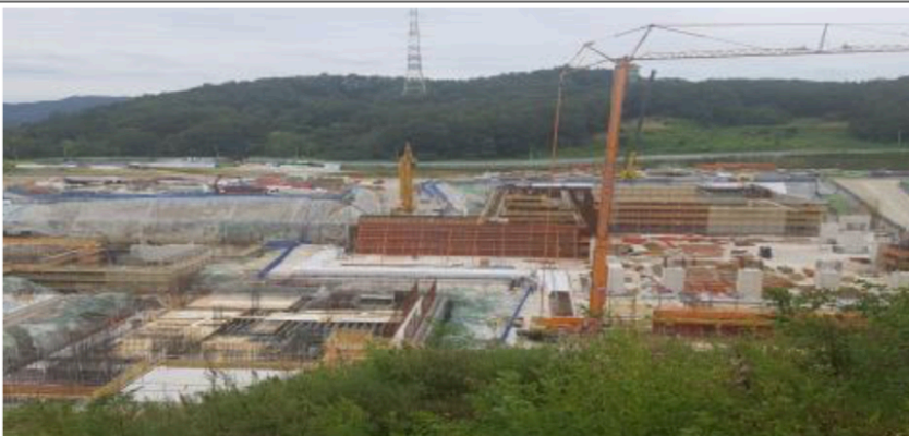
IF/고에너지A구역 (B1F 벽체 철근배근 및 Conc 타설)
