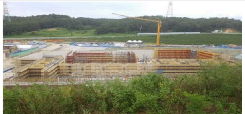
ISOL구역 (B1F 벽체 철근배근 및 Conc 타설)
