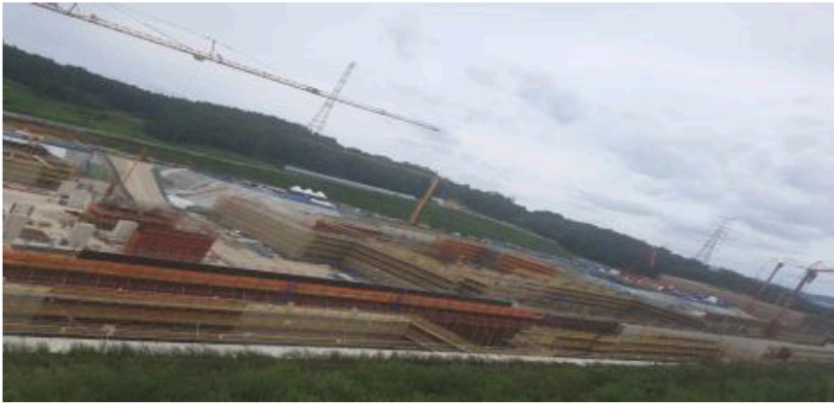
SCL2구역 (터널 벽체 철근배근 및 Conc 타설)
