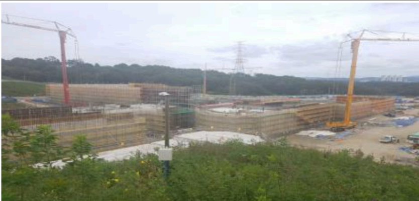
저에너지AB구역 (B1F 벽체 철근배근 및 Conc 타설)
