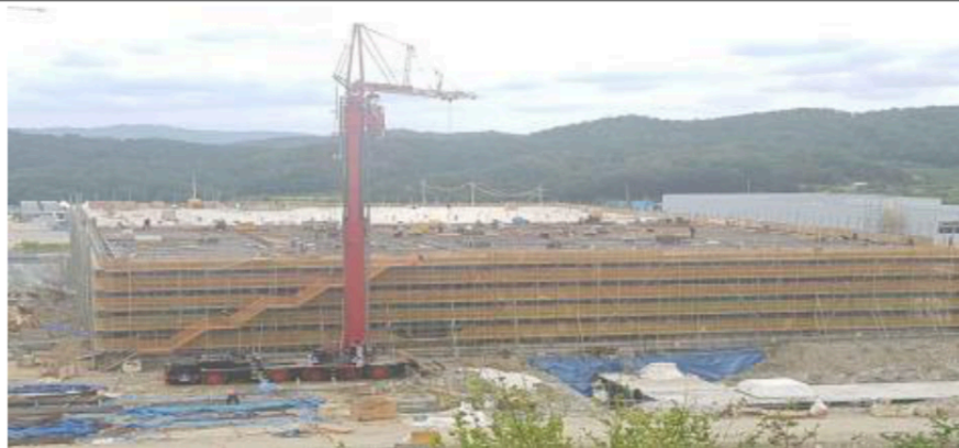
유틸리티동 (1F 벽체 철근배근 및 Conc 타설)
