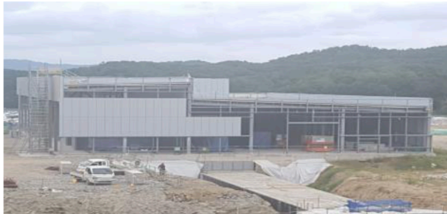
수전설비동 (하지철물 설치)
