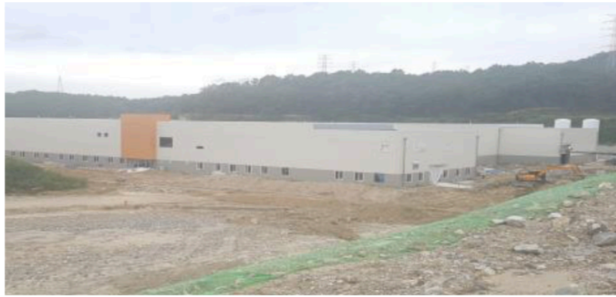
SRF시험동 (내부 마감 공사)
